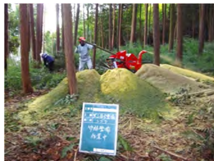
（使用する資機材の様子）
