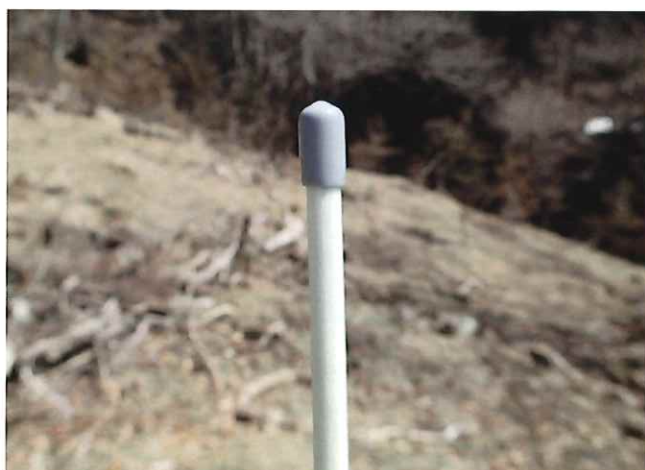
塩ビキャップを支柱の先端に取り付けます
